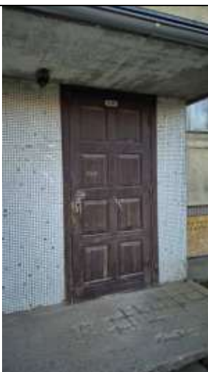
Kāpņu telpas ārdurvis
